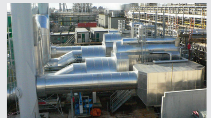
Паровой котёл-утилизатор для турбины Т70 Двухбарабанный, сухая камера сгорания Производительность макс. 2 x 30 т/ч с дожигом Давление 18 бар Температура 225°C Топливо: природный газ / дизтопливо Построен в 2006 году
