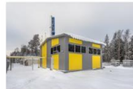
04-6МВт на базе котлов Polykraft
