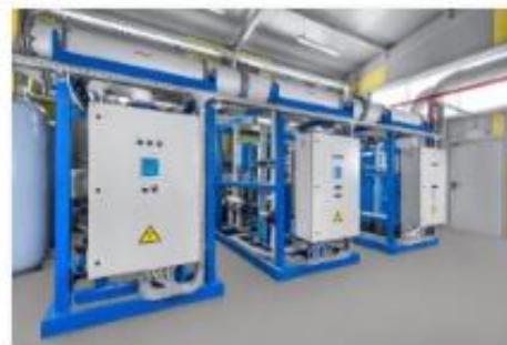
03-6МВт на базе котлов Polykraft
