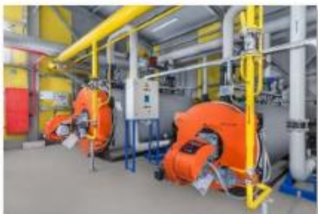
01-6МВт на базе котлов Polykraft
