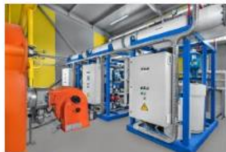
02-6МВт на базе котлов Polykraft
